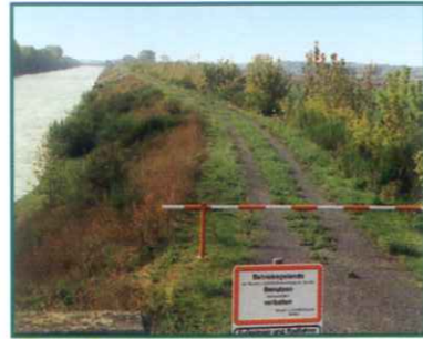
Kanalseitenwall mit Betriebsweg
