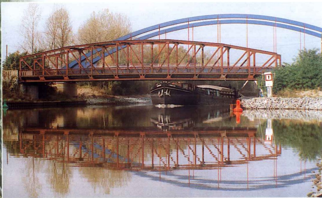
Brücke Nr. 454 bei MLK-km 273,5 Miesterhorst - Rätzlingen, alt und neu
