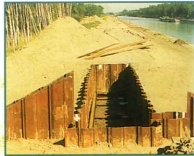
Fledermausquartier im Bau
