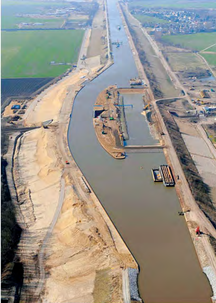
Bild 12 Ausweiche in Betrieb, Alte Fahrt gelenzt Bypass in use, main route "Alte Fahrt" pumped out
