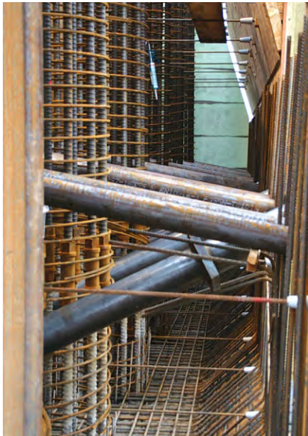
Bild 9, 10 Rohrdurchführungen der Verankerungselemente, Ansicht der Flügelwände Passing pipes for anchoring elements, view of return walls
