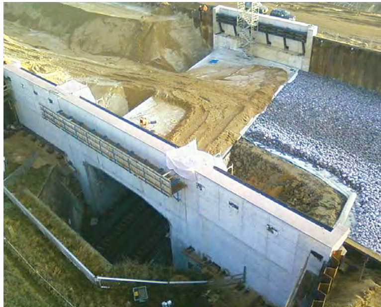
Bild 9, 10 Rohrdurchführungen der Verankerungselemente, Ansicht der Flügelwände Passing pipes for anchoring elements, view of return walls
