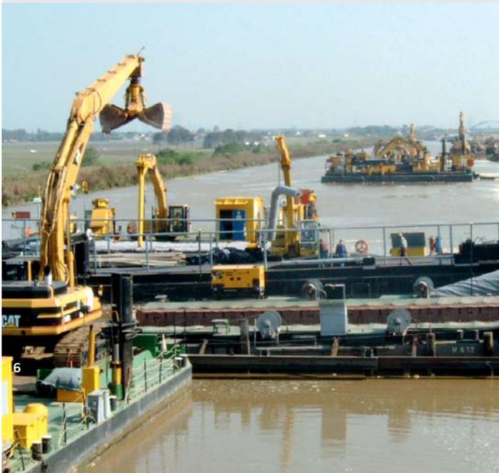
Abb. 6: Wasserbaugerätezug im Einsatz
