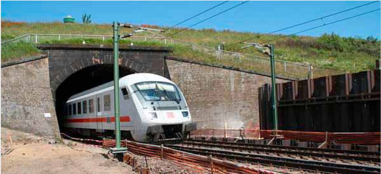
Abb. 6: IC-Durchfahrt unter der Kanalüberführung
