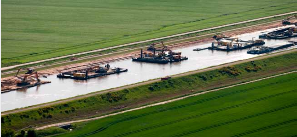
Abb. 1: Ausbau der Osthaltung des Mittellandkanals
