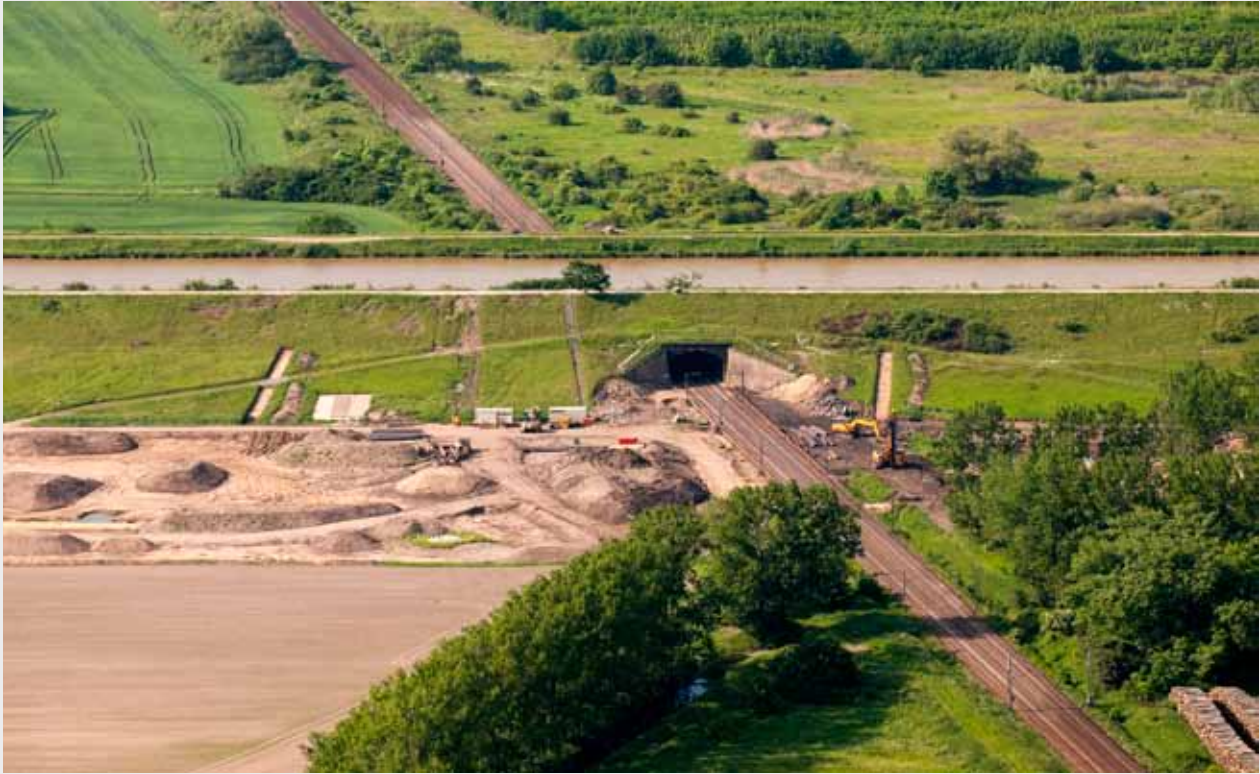
Abb. 5: Die Kanalüberführung Elbeu vor Beginn der Neubauarbeiten
