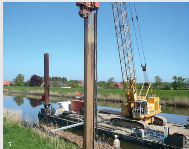
Abb. 5: Rammarbeiten am Schleusenoberkanal Langwedel
