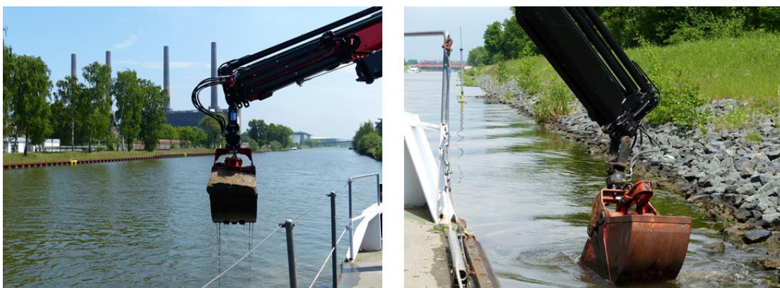
Abbildung 6: Entnahme der Proben mit Zweischalengreifer Linkes Bild: Entnahme von Feinsedimenten, rechtes Bild: Entnahme von Bruchsteinen aus der Steinschüttung
