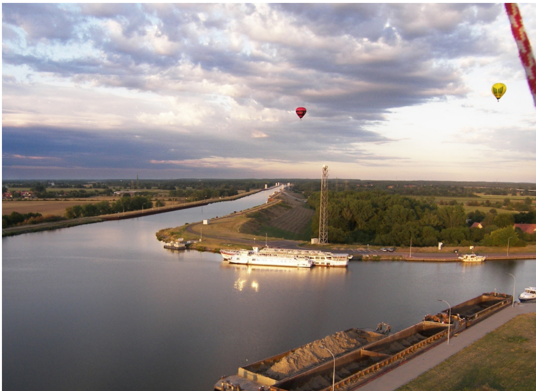
Abbildung 1: Der Mittellandkanal am Wasserstraßenkreuz Magdeburg
